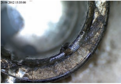
Abbildung 3 Biofilm (dunkle Beläge) an einem Wasserablaufrohr.
